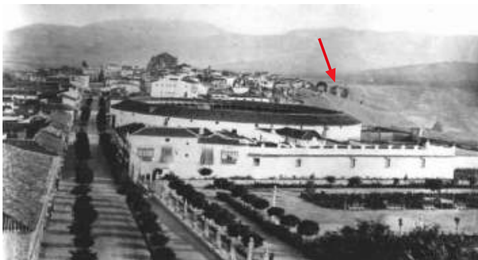
Vista de Ronda desde el norte. Con la flecha se señala la situación del Bastión Occidental (J. Laurent 1876-1879)
