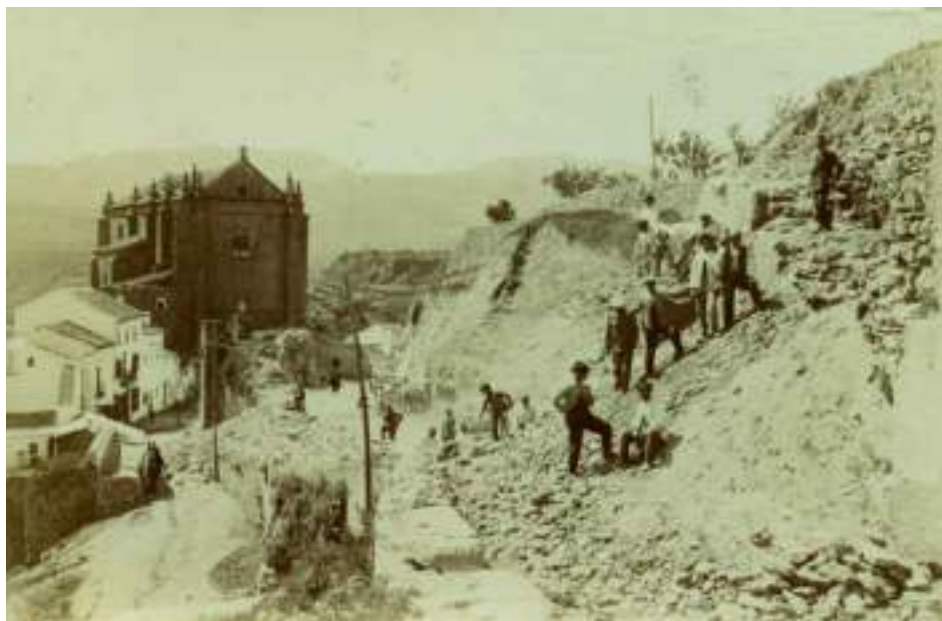
Demolición de la muralla del castillo en el entorno de la puerta de las Imágenes (J. Ortega Durán, 1912)
