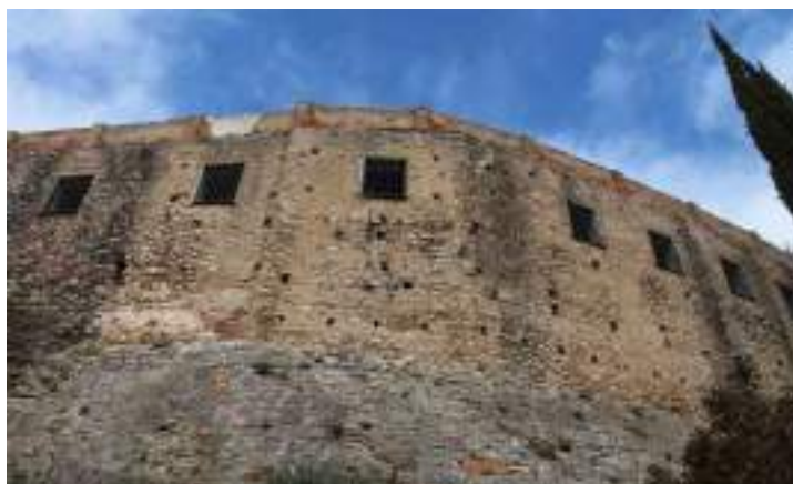
Muros perimetrales muy transformados de la alcazaba o castillo de Ronda (Foto Pedro Gurriarán)
