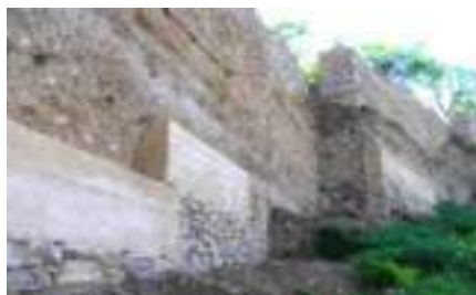
Detalle del tapial en Albacar
