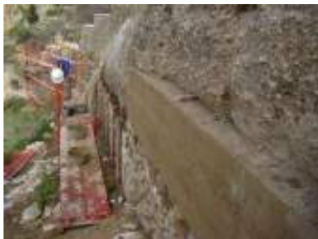
Muralla de tapia del Albacar de Ronda. Proceso de construcción de nuevas tapias de cal en la muralla del Albacar (2006). (Fotos Pedro Guarriarán)
