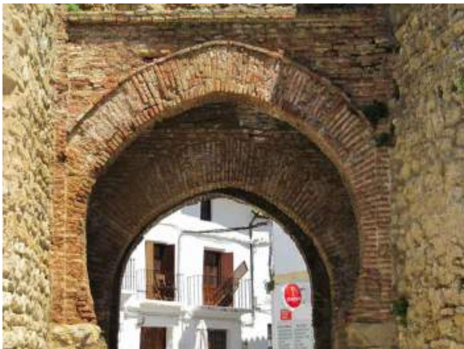
Distintas fábricas de ladrillo en el alzado exterior de la Puerta de Almocábar (Plan Director Murallas)
